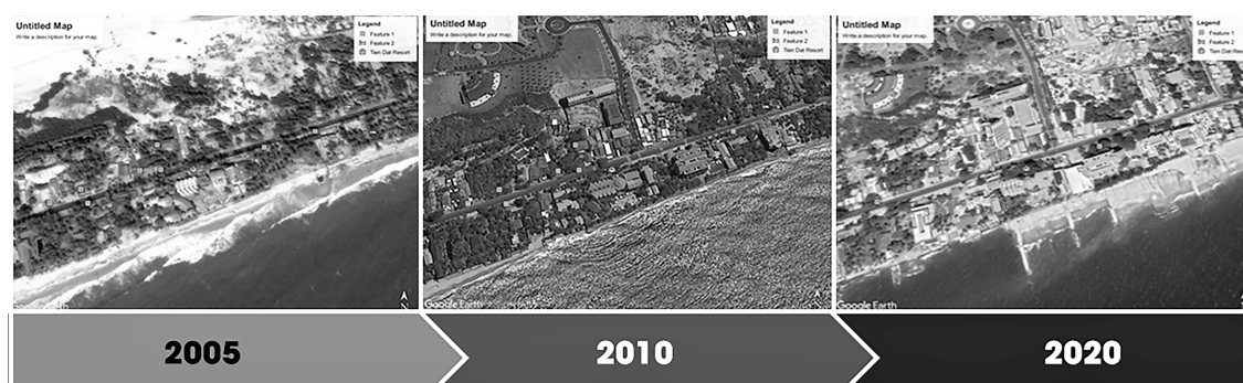
Hình 1. Thực trạng sạt lở bờ biển tại khu vực Hàm Tiến thuộc Tp. Phan Thiết [4]
